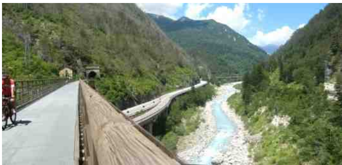
Fietspad over spoorlijn.
