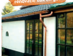
renovatie dak en goot
