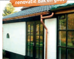
renovatie dak en goot
