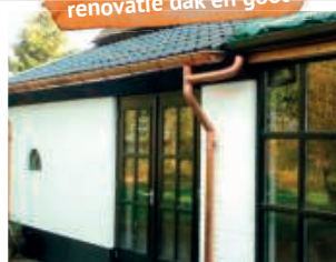
renovatie dak en goot
