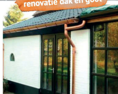
renovatie dak en goot
