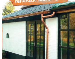
renovatie dak en goot
